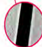
Spaltenboden im Kantenbereich gefast
